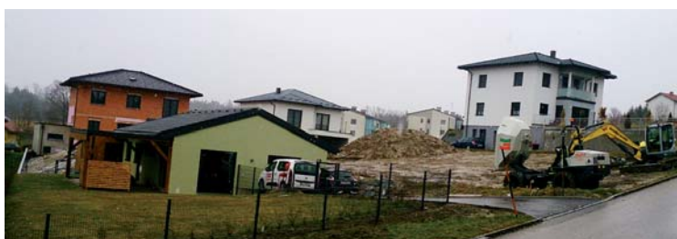
Am Höhenweg entstehen neue Eigenheime
