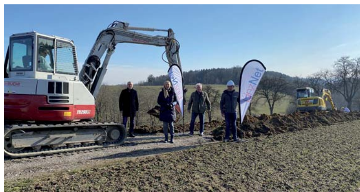
Machten sich einen ersten Eindruck vom Beginn der Grabungsarbeiten. v.l.: VBGM Gerhard Seemann, BGM.in Gabriele Aicher, Breitbandbeauftragter Gerhard Nöbauer und Florian Samhaber/Bauleiter LinzNet GmbH (Foto: Marktgemeinde Pichl bei Wels)
