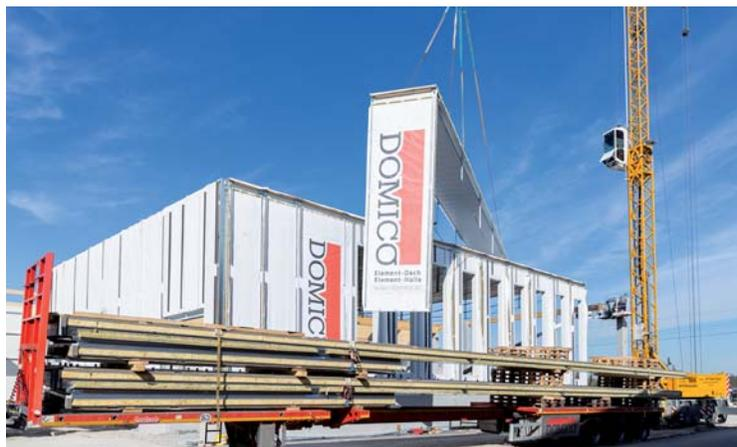
Durch das faltbare Traggerüst konnte die Markl Dachdeckerei/Spenglerei GmbH die Element-Halle in kürzester Zeit mit einem Mobilkran aufstellen. Behinderungen des laufenden Produktionsbetriebes wurden auf ein Minimum reduziert. (Foto: DOMICO)
